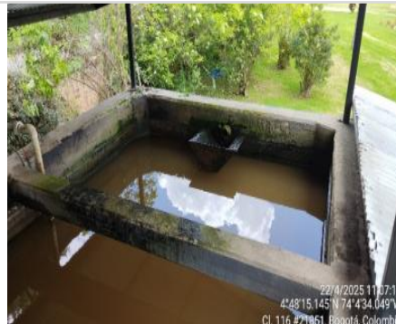
Fotografía No. 10. Ingreso del efluente a la unidad de cribado ( 4^{\circ}48'15.145''N - 74^{\circ}4'34.049''W )
