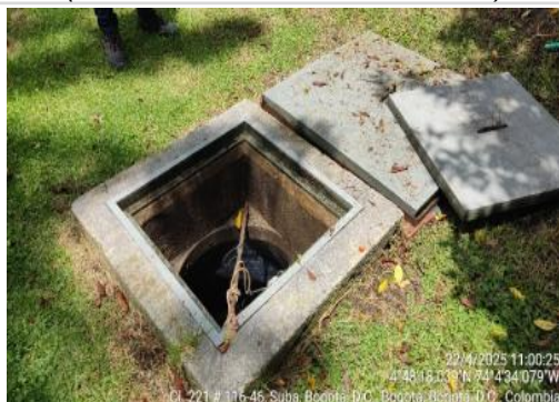
Fotografía No. 7. Pozo Séptico área canina. (4°48'18.039"N – 74°4'34.079"W)
