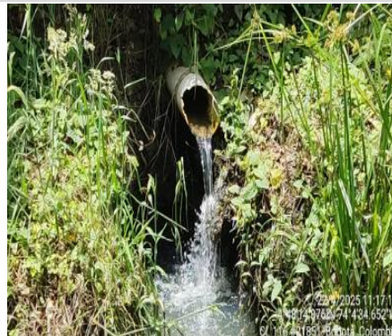
Fotografía No. 14. Estructura punto de vertimiento - Canal en tierra KR 116 ( 4^{\circ}48'14.876''N - 74^{\circ}4'34.652''W )
