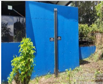
Fotografía No. 9. Ingreso del efluente a la unidad de cribado ( 4^{\circ}48'15.32''N - 74^{\circ}4'34.099''W )
